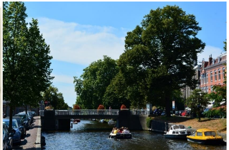
DSC_00016276 ; AV ; 15-7-2018 ; Vergelijkbare situatie als op de afbeelding links
