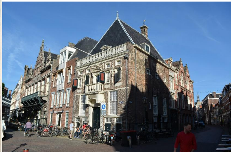
DSC_3623 ; AV ; 10-9-2016 ; Vergelijkbare situatie als prent links. Let op de verdwenen hijsbalk boven het dakraam aan de zijgevel langs de Smedestraat
