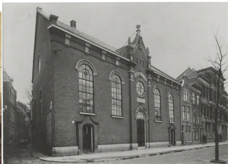
NL-HlmNHA_08240 ; R. van der Werf ; 1919 ; Gereformeerde kerk van de Christelijke Afscheiden Gemeente op de hoek Gedempte Oude Gracht / Stoopsteeg, nu de Wilhelminakerk. Deze kerk heeft hier gestaan van 1883?-1919.
