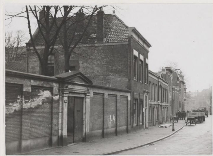
NL-HlmNHA_54000265 ; ? ; 1931 ; Locatie latere Brandweerkazerne, voorafgaand aan de bouw ervan. Gezicht richting oost
