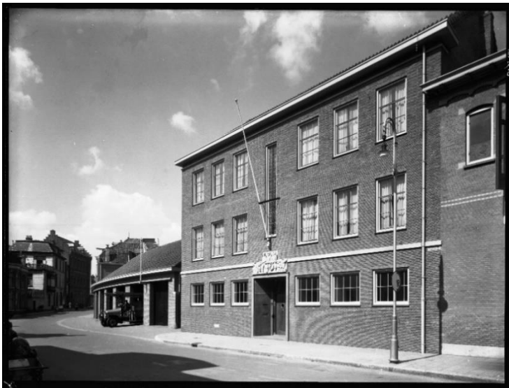
NL-HlmNHA__OW_0000D7-12 ; ? ; ? ; Brandweerkazerne Gedempte Oude Gracht 135, gezicht richting noordwest. Foto mogelijk genomen vlak na de bouw in 1937,
