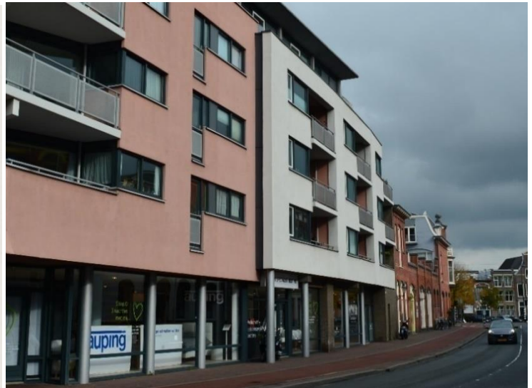
DSC_00021102 ; AV ; 15-10-2019 ; Gedempte Oude Gracht, hoek De Witstraat, gezicht richting oost. Vergelijkbare situatie als op foto links
