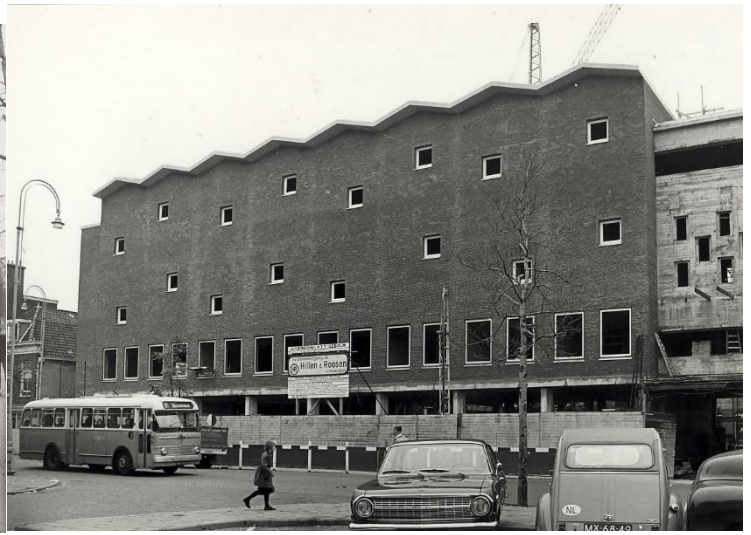
Noord Hollands Archief : KNA006008839 ; C. de Boer ; 1965 ; Gezicht op noordzijde van Raaks tussen Bakkumstraat(links) en Korte Zijlstraat(rechts) met telefooncentrale van postkantoor in aanbouw
