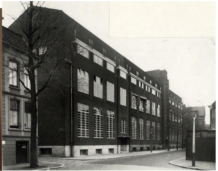
Noord Hollands Archief, KNA006012237 ; J. Stevens (Fotobureau Stevens) ; 1939 ; Vergelijkbare positie als foto links. De uitbreiding van het postkantoor rond 1939 is herkenbaar aan de lichtere kleur van de dakbedekking en de natuurstenen plint langs het trottoir
