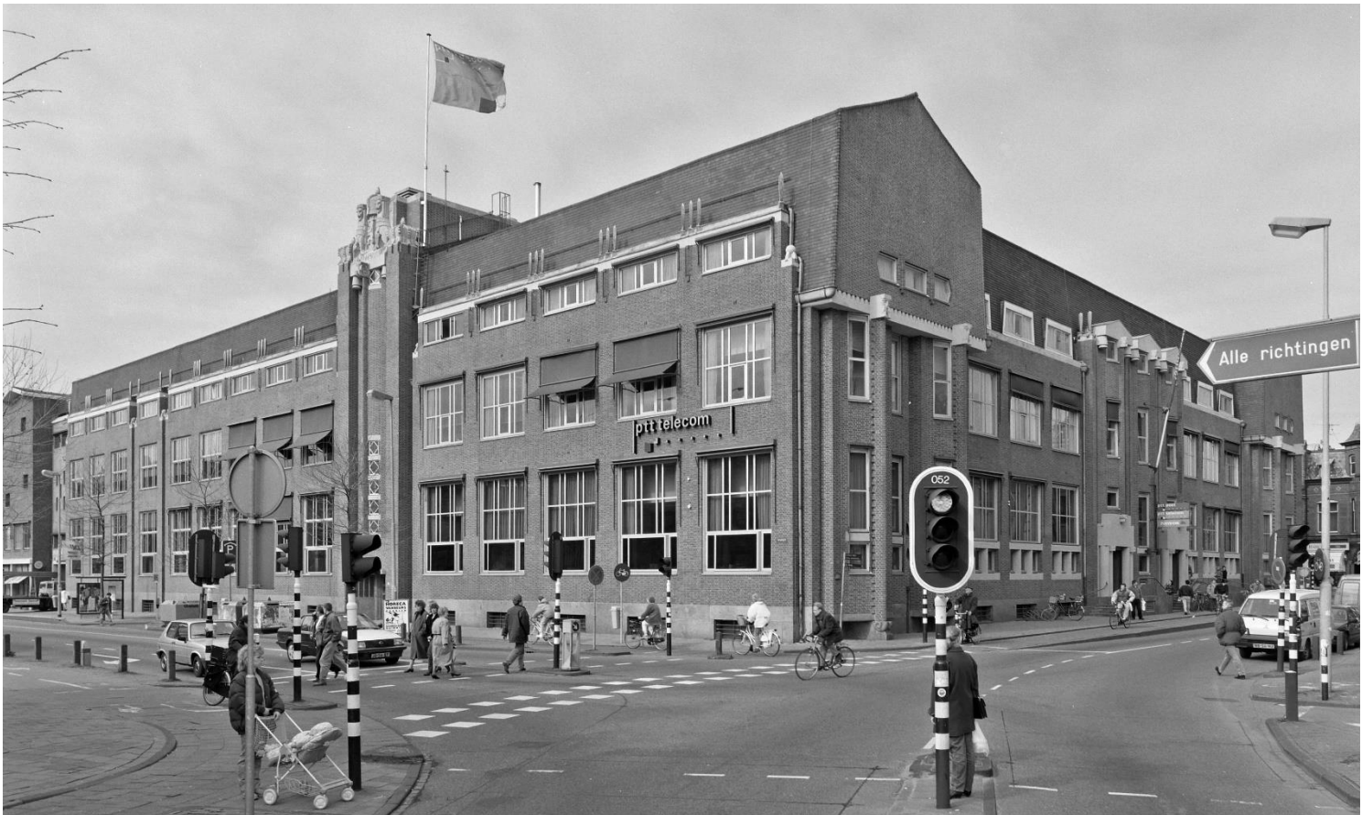
NL-HlmNHAJosF19921213_033 ; J. Fielmich ; 1992 ; De zeer karakteristieke ladderramen rond 1970 vervangen door deze "standaardramen". Gelukkig zijn deze ramen door de verbouwing naar Stadskantoor Zijkpoort weer vervangen door kopieën van de originele ladderramen.
