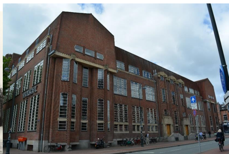
DSC_6628 ; AV ; 2-7-2017 ; Vergelijkbare locatie als foto links. Voorgevel van het voormalige hoofdkantoor met voormalige hoofdingangen.
