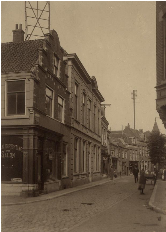
NL-HlmNHA_54018152 ; B. Zweers ; 1918 ; Zijlstraat bij kruising Nassaulaan, gezicht richting west. (NHA had abusievelijk 1915 als jaartal vermeld). Complex vlak voor de sloop
