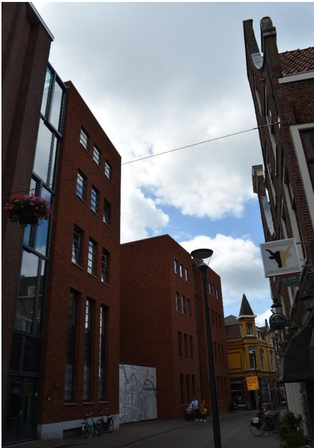
DSC_6612 ; AV ; 2-7-2017 ; Zijlstraat, gezicht richting west op nieuwe uitbreidingen (2010-2014) van vroegere postkantoor
