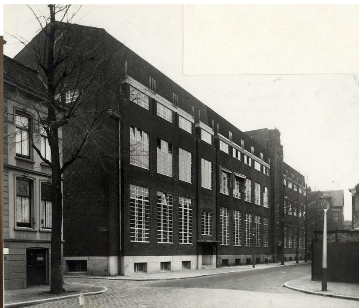
Noord Hollands Archief, KNA006012237 ; J. Stevens (Fotobureau Stevens) ; 1939 ; Vergelijkbare positie als foto links. De uitbreiding van het postkantoor rond 1939 is herkenbaar aan de lichtere kleur van de dakbedekking en de natuurstenen plint bij het trottoir
