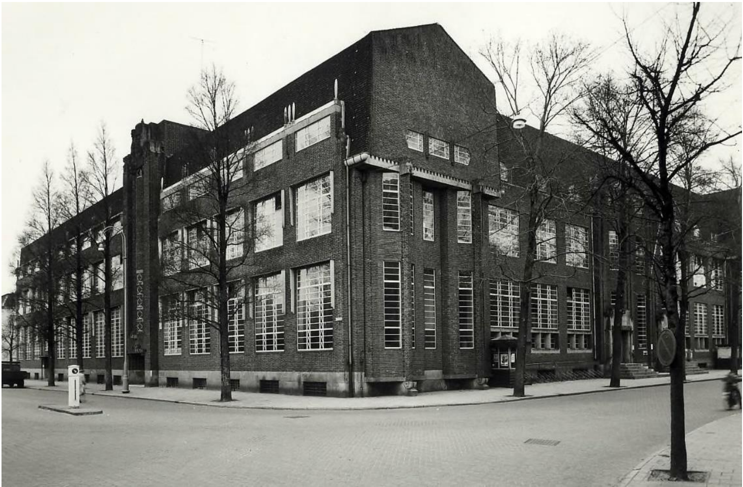
NL-HlmNHA_1100_KNA006006025 ; W.J. van Borselen ; 1950 ; Postkantoor met de originele zeer karakteristieke ladderramen
