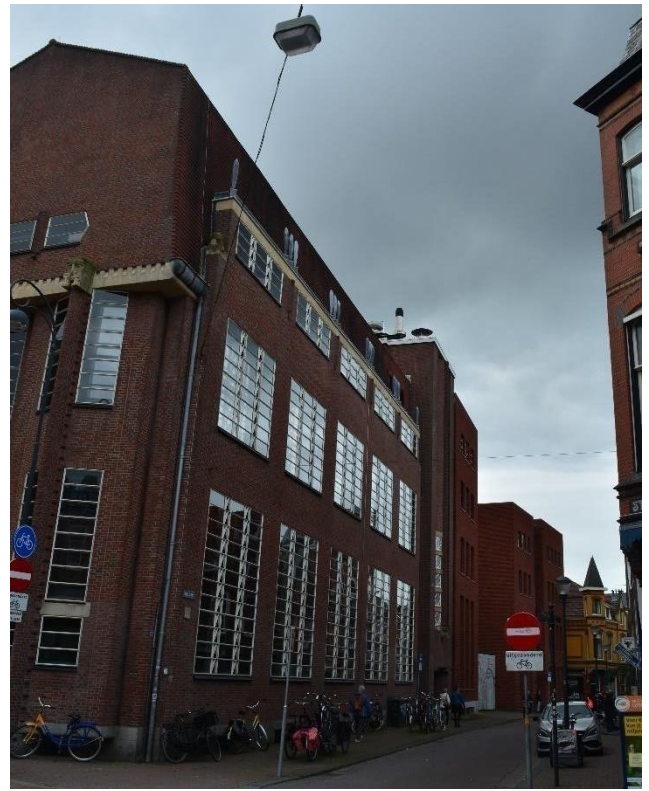
DSC_00021104 ; AV ; 15-10-2019 ; Vergelijkbare situatie als op foto links. Pal rechts van het midden de nooit voltooide toren
