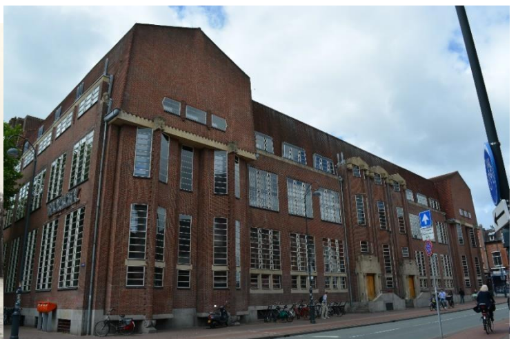
DSC_6628 ; AV ; 2-7-2017 ; Vergelijkbare locatie als foto links. Voorgevel met voormalige hoofdingangen
