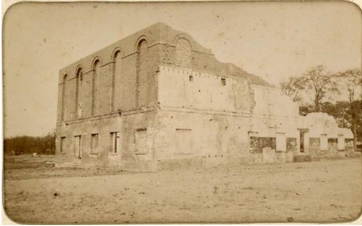
NL-HlmNHA_1100_KNA006013065 ; ? ; 1897 ; ruïne van de 2 e katoenfabriek van Wilson. Gezichtsrichting niet geheel duidelijk.
