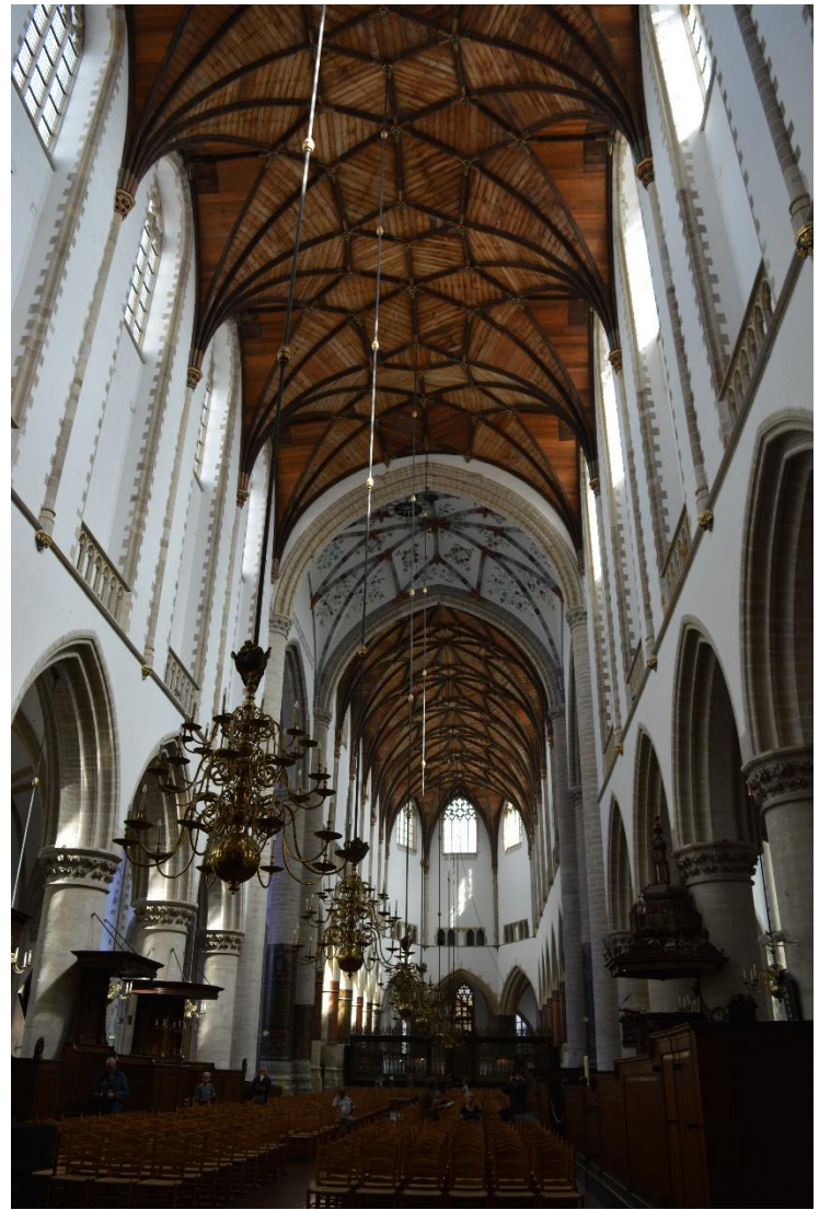
DSC_8545 ; AV ; 24-8-2017 ; Overzicht van middenschip en koor richting oost
