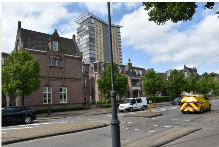
DSC_00039489 ; AV ; 16-5-2025 ; Haarlem, Kamperlaan hoek Vlietsorgstraat, gezicht richting westzuidwest op de vroegere Mariastichting. Locatie is vergelijkbaar met die van afbeelding links. Deze foto geeft aan hoe de omgeving verstedelijkt is en veel minder rustig.
