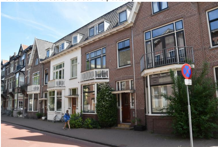
DSC_0009453 ; AV ; 14-5-2025 ; Haarlem, Kleine Houtweg tussen Krelagestraat en Bloemhofstraat, gezicht richting noord oost. Locatie vergelijkbaar met afbeelding hierboven.
