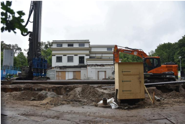
DSC_00036150 ; AV ; 13-07-2024 ; Dreefzicht in verbouwing. Kant van de gesloopte moderne uitbreidingen. Gezicht richting oost
