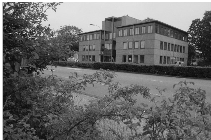
Haarlem, Noord-Hollandsarchief, beeldbank De Boer, Inventarisnummer NL-HlmNHA_1478_34501K00. Datum: 5-6-1991. Extérieur kantoorgebouw in aanbouw, Zuiderhoutlaan 4. Zie ook foto links
