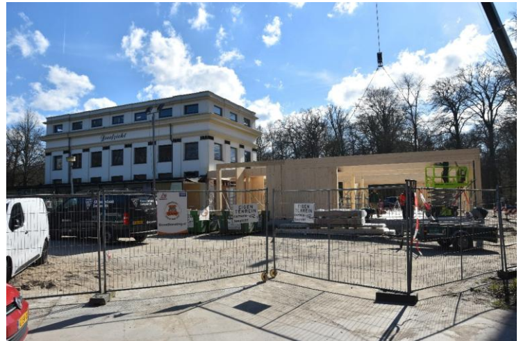
DSC_00039233 ; AV ; 17-03-2025 ; Dreefzicht in verbouwing. Gezicht richting zuid
