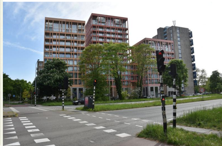
DSC_00039348 ; AV ; 3-5-2025 ; Haarlem, Wagenweg kruising Westelijke Randweg, gezicht richting zuidwest op het complex De Houtwachters. Dit complex is de vervanging van het kantoor Houthof op de afbeelding links. Foto vergelijkbaar met afbeelding links.
