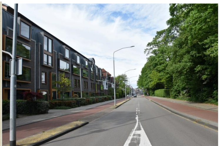
DSC_00039331 ; AV ; 3-5-2025 ; Wagenweg even ten noorden van de Spruitenbosstraat. Gezicht richting noord. Zou deze plek overeenkomen met die van de afbeelding links? Deze twee afbeeldingen geven in ieder geval wel weer hoe de Wagenweg in de loop der tijd veranderd is.
