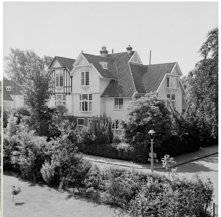
Haarlem, Noord-Hollands archief, Beeldbank De Boer, inventarisnummer NL-HlmNHA_1478_02547A00_01. Datum: 4 september 1969. Oosterhoutlaan, gezicht richting zuid. Gebouwen van het toenmalige Diaconessenhuis.
