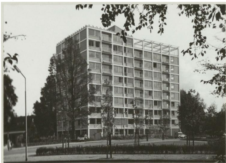
Haarlem, Noord-Hollandsarchief, collectie 1478 foto's en negatieven van Fotopersbureau De Boer te Haarlem, Inventarisnummer 4909. Datum: 1960. Parkflat Zuiderhout in aanbouw, noordwestzijde aan de Prins Mauritslaan, hoek Willem de Zwijgerlaan
