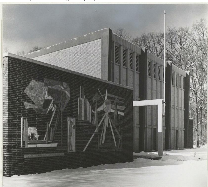
Haarlem, Noord-Hollands archief, collectie 1100 van gemeente Haarlem, Inventarisnummer 24629. Maker: W.M. Zilver Rupe. Datum maart 1958, 50 kilovolt-station aan de Kleine Houtweg hoek Linnaeuslaan. Het gebouw is ontworpen door de architect D. Heiloo en het mozaïek is van Lex Horn
