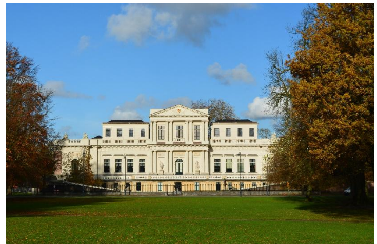
DSC_00010869 ; AV ; 17-11-2017 ; locatie idem afbeelding boven. De lichtkappen op de zijvleugels zijn weer in ere hersteld
