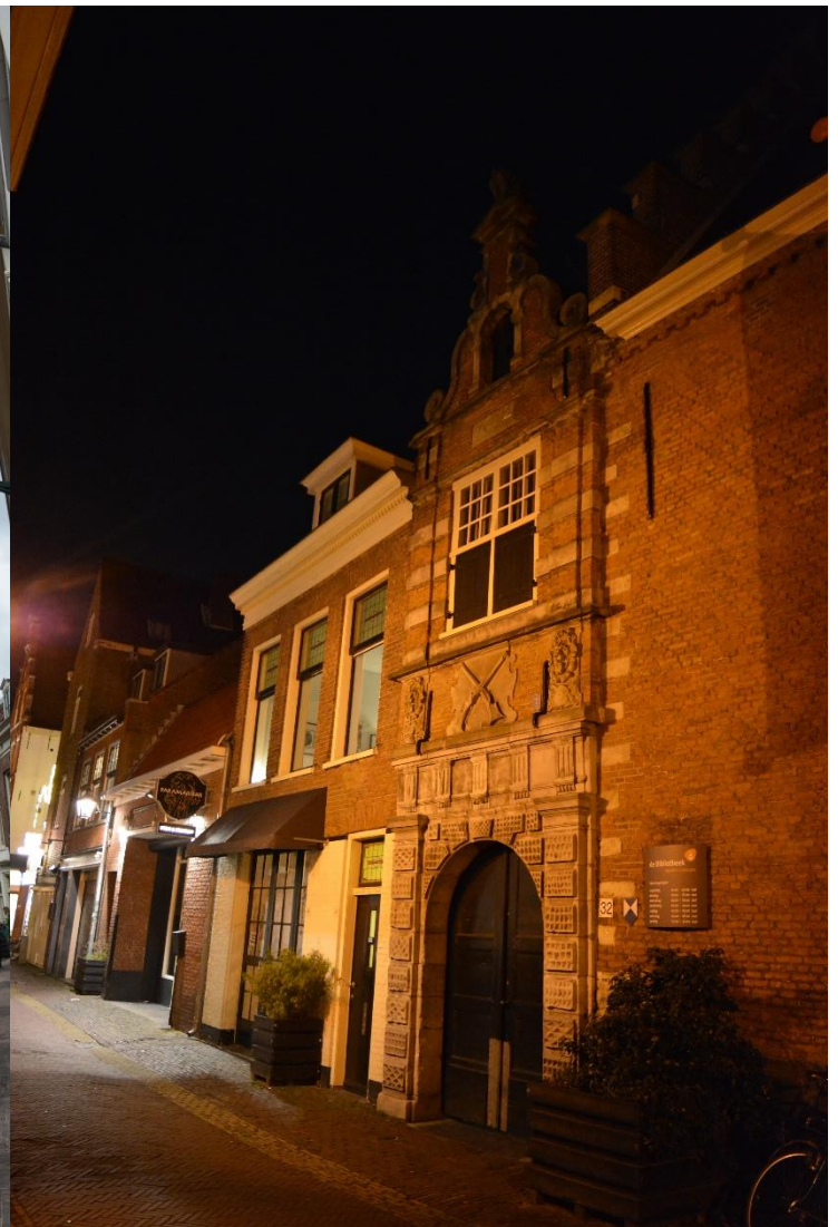
DSC_00022408 ; AV ; 10-1-2020 ; Gasthuisstraat met toegangspoort tot binnenplaats en stadsbibliotheek. Gezicht richting zuidwest
