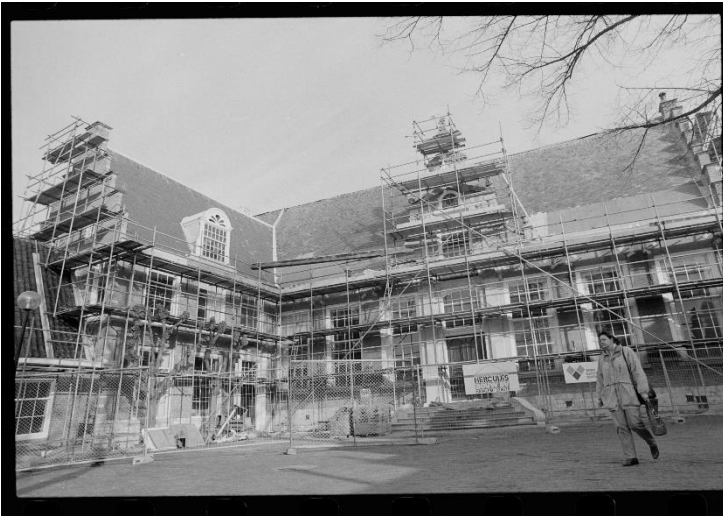
Noord-Hollands archief, Beeldbank De Boer, rep.nr. L35987 ; 21-2-1995 ; het oude Doelengebouw in de steigers. Eindelijk de lang verwachte restauratie
