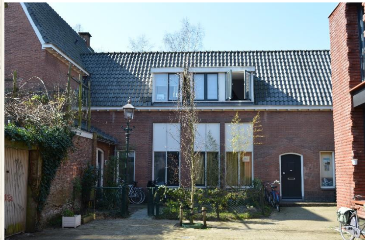
DSC_00022557 ; AV ; 26-3-2020 ; Vergelijkbare situatie als op afbeelding links
