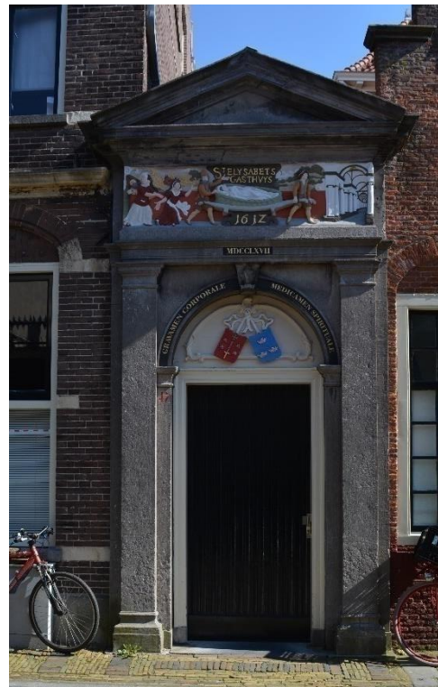
DSC_00022560 ; AV ; 26-3-2020 ; Vergelijkbare situatie als op afbeelding links
