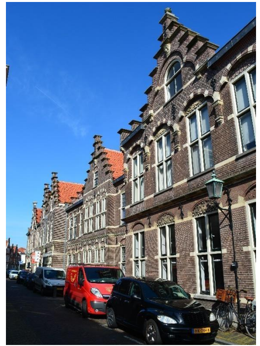
DSC_5912 ; AV ; 24-3-2017 : Vergelijkbare situatie als foto links en hierboven
