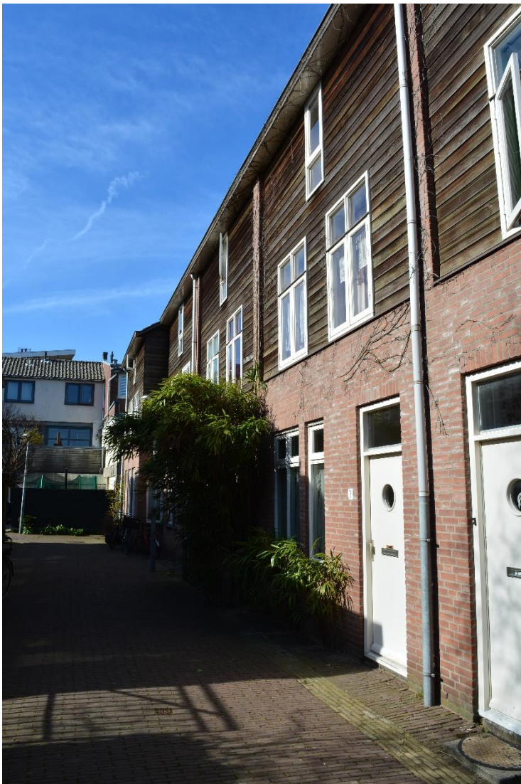
DSC_5935 ; AV ; 24-3-2017 ; dwarssteeg Frieseport, gezicht richting west op de noordzijde
