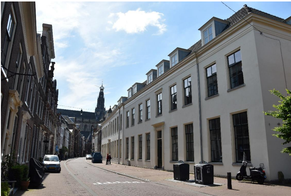
DSC_00032823 ; AV ; 19-5-2023 ; Jansstraat, gezicht richting zuid op het zojuist tot stadsappartementen verbouwde complex van het Voormalig Kantongerecht
