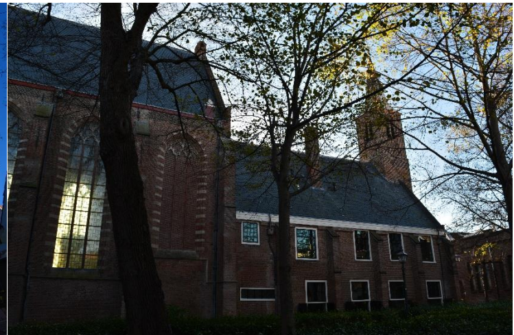
DSC_0002349 ; AV ; 18-11-2020 ; gezicht richting zuidwest op de Waalse Kerk
