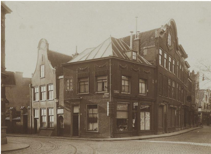
NL-HlmNHA_10273 ; ? ; 1931 ; gezicht richting zuid op de hoek van de Lange Veerstraat (rechts) / Damstraat (links). Deze hoek is kort na de opname gesloopt voor de verbreding van de Damstraat.
