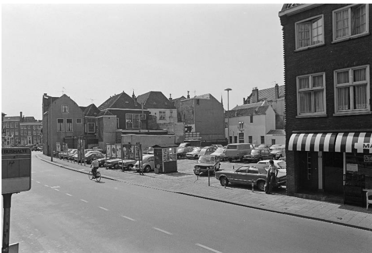
NL-HlmNHAJosF19760512_150 ; J. Fielmich ; 1976 ; Damstraat, gezicht richting zuidoost op het gat aan de zuidzijde van de Damstraat.
