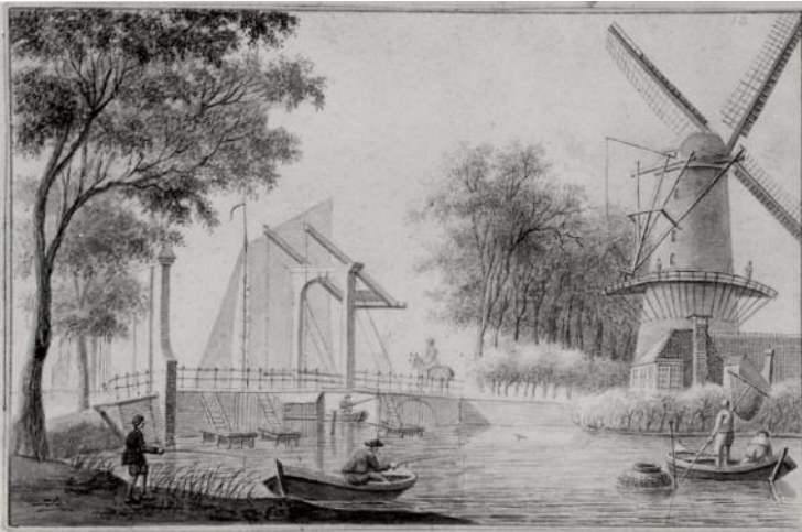
NL-HlmNHA_53500553 ; J. Pannebakker ; ? ; Gezicht op het Vrouwehek en het Fortuin richting oost. Datum is onduidelijk. De aan de molen grenzende bebouwing ziet er heel anders uit dan de aangrenzende bebouwing op prenten van VOOR de brand in 1830. Dus is deze prent mogelijk van na 1831, het jaar van de herbouw van de molen.
