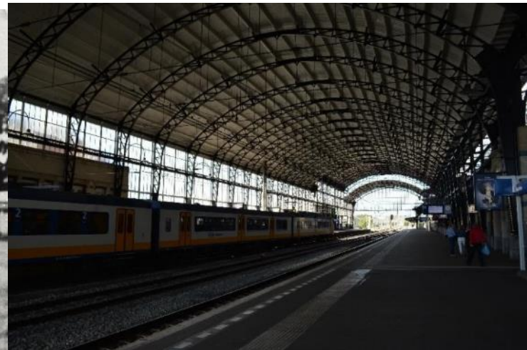
DSC_00017087 ; AV ; 30-9-2018 ; Vergelijkbare positie als op foto links, alleen een etage hoger. Bovenstaande foto is genomen bij de oostelijke tunnel op spoor 3, gezicht richting zuidwest
