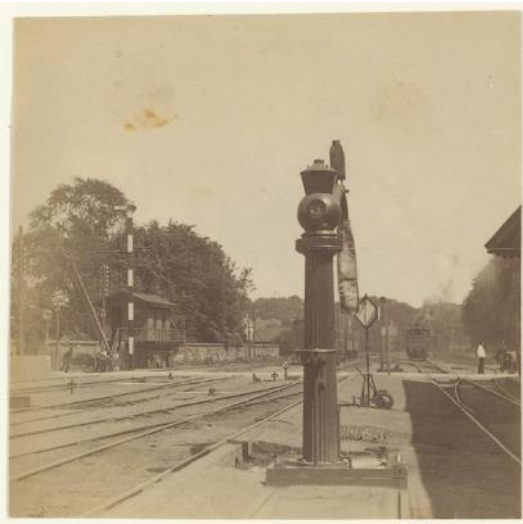
NL-HlmNHA_54007281 ; ? ; 1875; Station Haarlem III, gezicht vanaf het perron richting oost op de spoorwegovergang Jansweg
