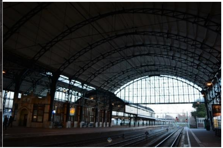
DSC_00011241 ; AV ; 8-1-2018 ; Vergelijkbare situatie als op de foto links, zij het een etage hoger genomen en met een wat breder perspectief
