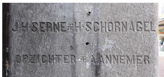
Aan de rechterzijde van de ingang zijn de namen van de opzichter en de aannemer aangebracht.
